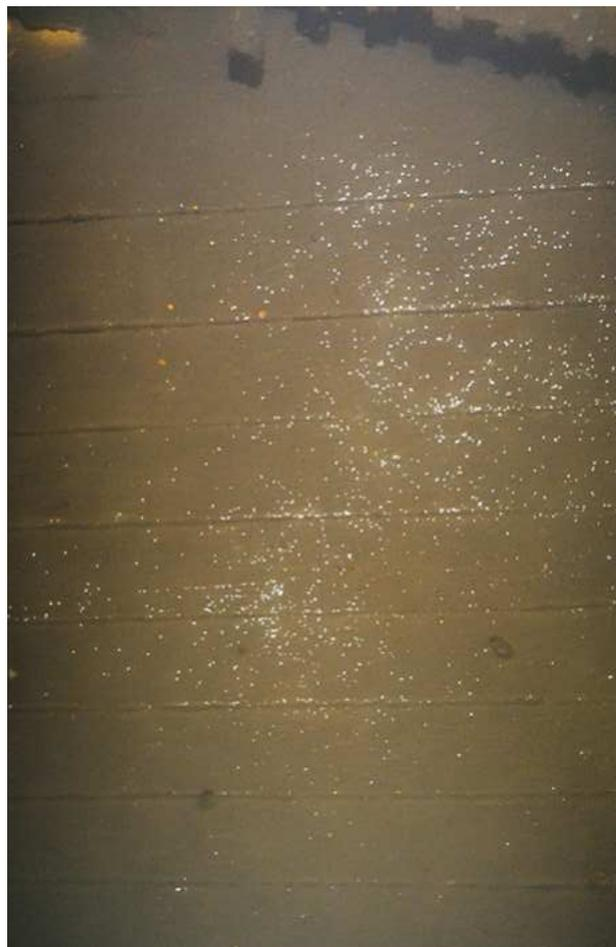
*Рис. 5. Гидроксид кальция (белые точки) на однородной поверхности судна*
