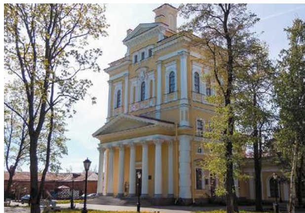
Рис. 18. Музей истории Кронштадта. Экспозиция «Подводная археология» в здании бывшей водонапорной башни (Из архива авторов)
