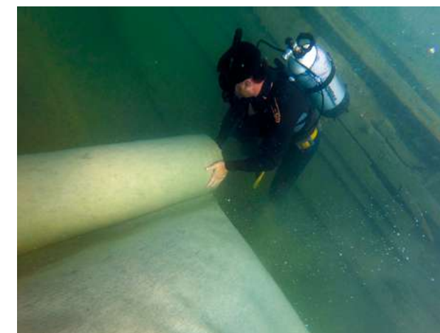
Рис. 7. Консервация останков затонувших судов слоем геотекстиля. Из архива автора
