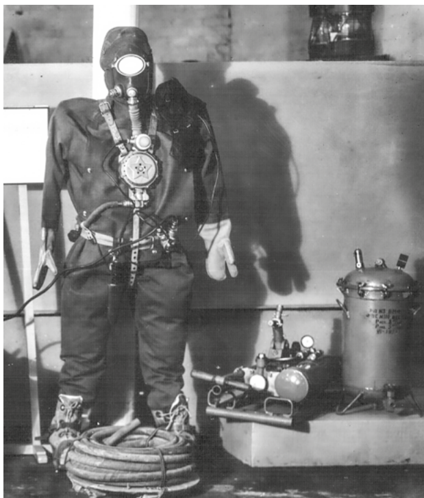
Рис. 11. Комплект облегченного водолазного снаряжения СВВ-55, в состав которого, помимо собственно снаряжения, входят облегченная воздушная помпа ОВП и воздушный фильтр среднего давления ФВС-55
