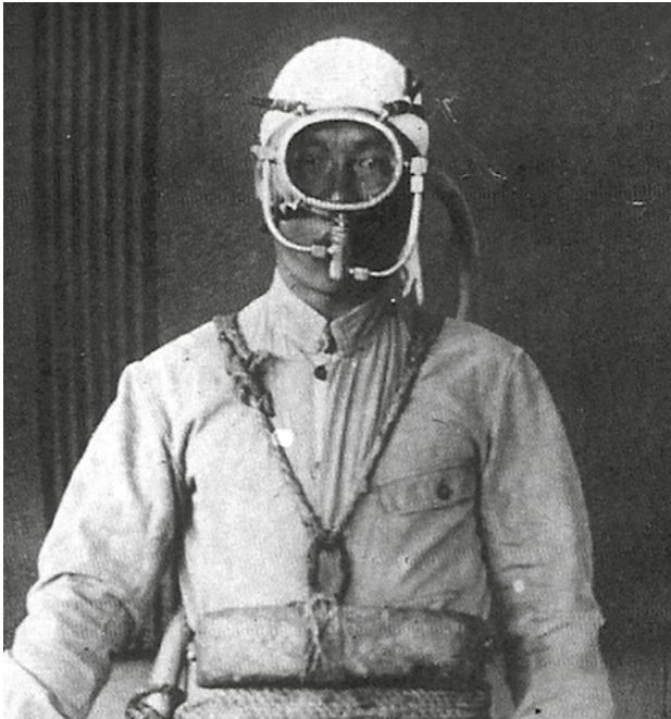
Рис. 4. Японский водолаз в дыхательной маске Оогуши, ставшей прототипом рейдовой маски ЭПРОНа
