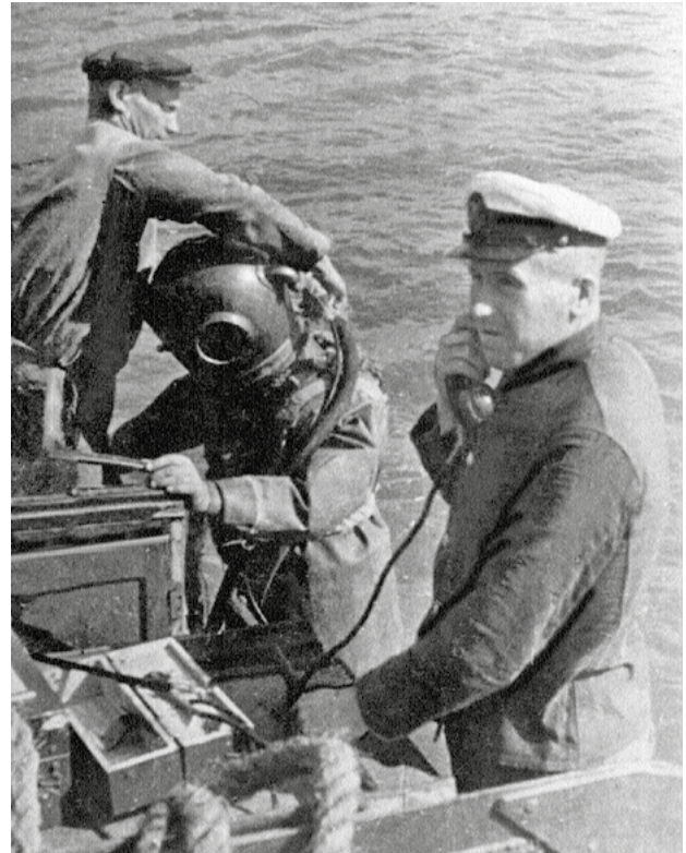
Рис. 18 а, б. Телефонный аппарат связи с водолазом, созданный ЭПРОНОм на базе полевого телефона
