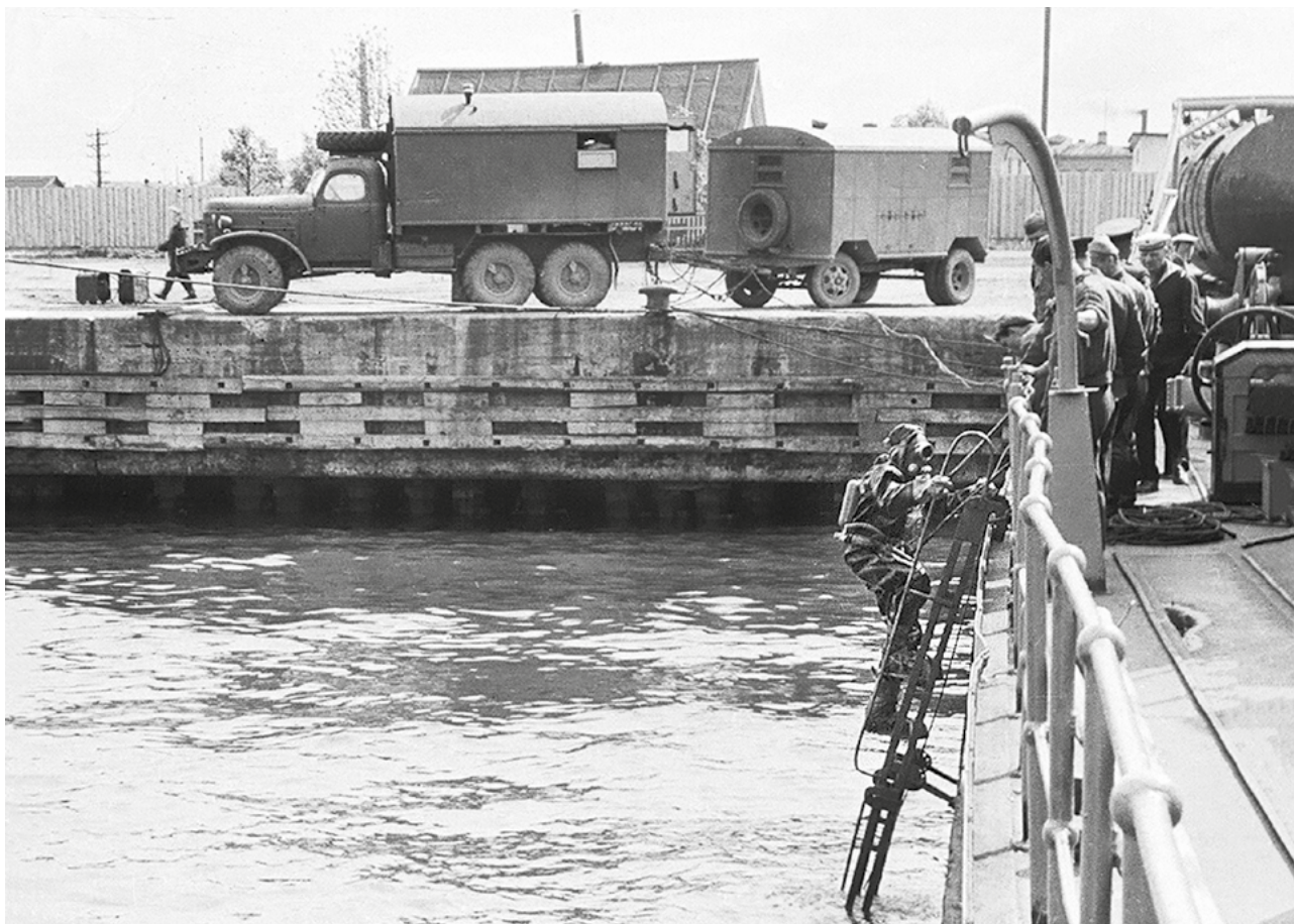
Рис. 12. Водолаз инженерный войск в снаряжении СВВ-55. Работа водолаза обеспечивается передвижной водолазной станцией на автоходу
