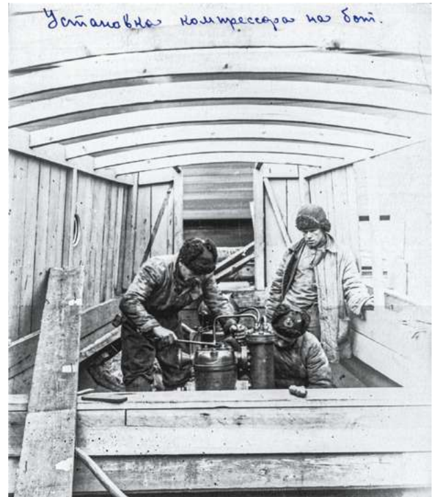
Рис. 25. Строительство силами мастерских ЭПРОНа водолазного бота. Установка мотокомпрессора
