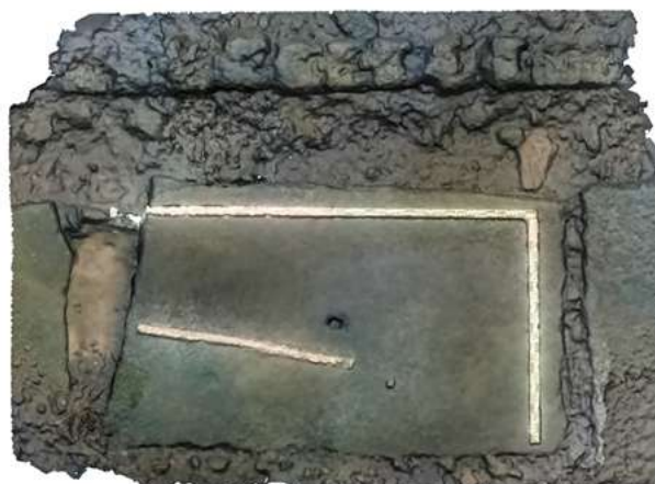
Рис. 2. Плита основания и ряд шпунтовых свай. Модель на основе фотограмметрии
